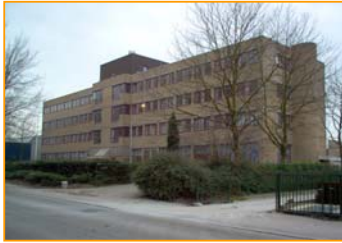
Een van de door Magielsen (2004) onderzochte cases: kantoorpand aan de Rotterdamseweg in Delft. Bouwjaar 1982; 5.150 m 2 VVO.
