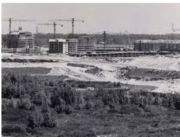
Figuur 1.2: Nellestein in aanbouw. Gezien vanaf Huigenbos. Bron: Stadsarchief Amsterdam.
