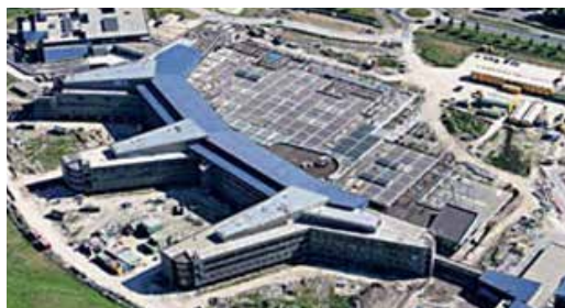
FIGUUR 7.188 luchtfoto complex
