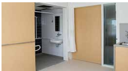
FIGUUR 11.46 patiëntenkamer tijdens de bouw
