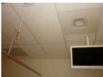
FIGUUR 7.60 zicht vanuit het bed van de patiënt naar het plafond met rail bedgordijn en klimaatrooster
