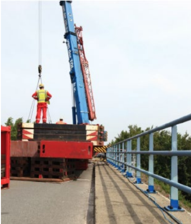
Figura 2. Prueba de carga en el puente Zijlweg.
