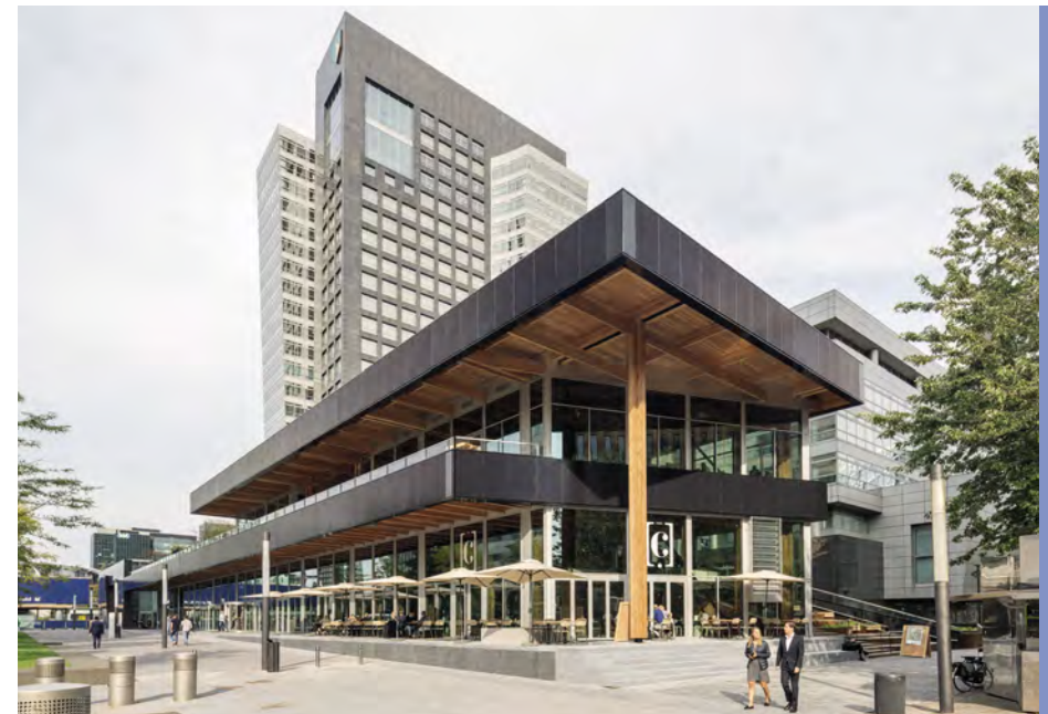
In het Circl paviljoen in Amsterdam (Architecten Cie.) zijn de glulam-balken demontabel en overgedimensioneerd, waardoor bij einde levensduur de balken met commerciële maten vrijkomen. De leverancier (Derix) heeft aangegeven de glulam-balken en CLT panelen terug te willen nemen.
