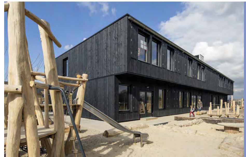
De tijdelijke school Nieuw Amsterdam (SeArch) bestaat uit CLT-modules die over vijf jaar worden gedemonteerd en op een nieuwe locatie opnieuw worden opgebouwd.
