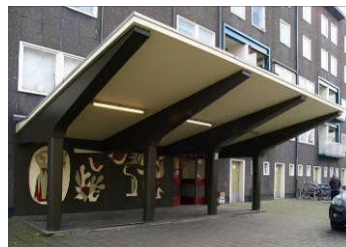
Fig. 2.126. De kleuren op de betonnen constructieonderdelen verschieten af en toe van kleur. Links boven een foto uit het archief van Arend Maaskant (rond 1980) de rest uit 2009.
