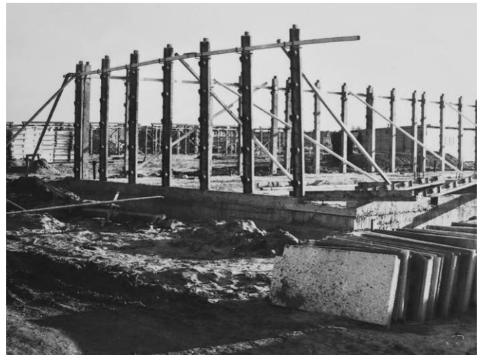
Fig. 2.102. Het Dôtremont-Ten Bosch systeem toegepast in Frankendaal (Zijlstra 2003).
