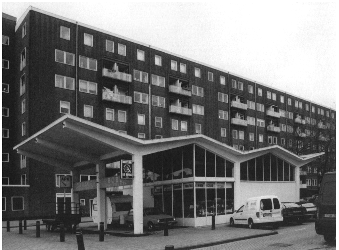
Fig. 2.13. Eén van de twee service-stations (Messcheart 2004).
