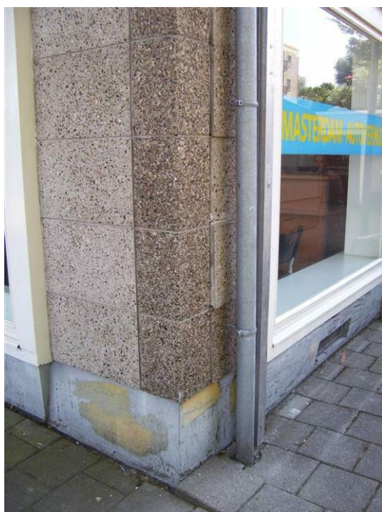
Fig. 4.10. Verplaatsing verschillende beton panelen.
