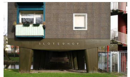
Fig. 2.126. De kleuren op de betonnen constructieonderdelen verschieten af en toe van kleur. Links boven een foto uit het archief van Arend Maaskant (rond 1980) de rest uit 2009.
