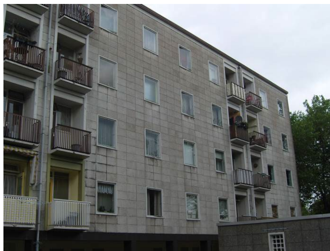
Fig. 4.1. Overzicht van een deel van één van de achtergevels. De geprefabriceerde beton panelen zijn in goede staat.
