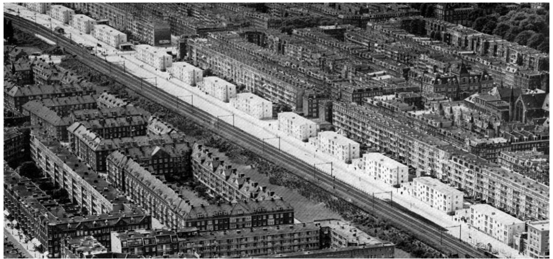
Fig. 2.100. Het project Populierenweg in het Nemavo-Airey systeem (Fischer 1968).
