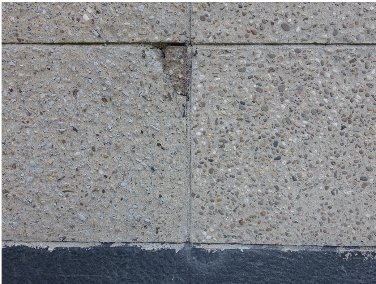
Renovatie 18 april 2016 (H. Zijlstra) Gevelpanelen van verf ontdaan, proefvlakken.
