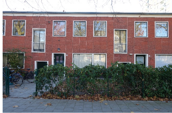
Amsterdam Slotershof, splitlevel atelier woning
