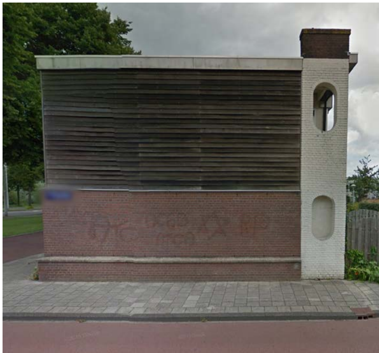
Hugo de Vrieslaan 129 juni 2014, laatste woning gerestaureerd, gevelpanelen, dakrand en goot. Rechterwoning geschilderd inclusief schoorsteen, dakrand en kozijnen kunststof Kopgevels bekleed en geschilderd
