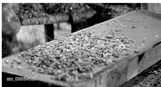
Afbeelding 10: Stills uit Country houses (zie noot 1). Plaatsing van de draad, ter wapening van het betonelement (a) waarvan de uiteinden gebruikt werden voor het bevestigingen van de elementen (b). De gevelelementen werden seriematig gemaakt en als laatste stap voor de verharding werd een laagje fijn grind ingetrild (c). Kenmerkend voor het UK-Airey-systeem zijn de betonnen spanten (d).
