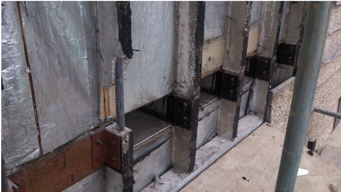
Afbeelding 11: Engels Airey-skelet na verwijderen gevelbeplating. Duidelijk zichtbaar zijn de aan de kolommen ingeklemde vloerbalken, de vorm van de gevelpanelen, de stalen wapeningsbuis, de aluminiumfolie aan de buitenzijde van de binnenafwerking en forse schade aan één van de betonkolommen.
