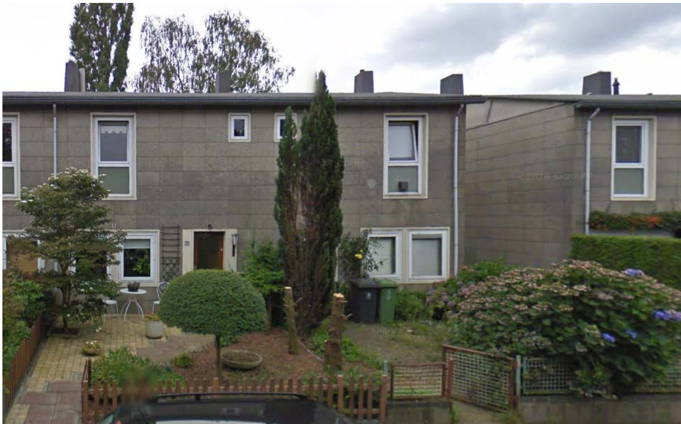
Jan Bottemastraat september 2010, breed 9 panelen
