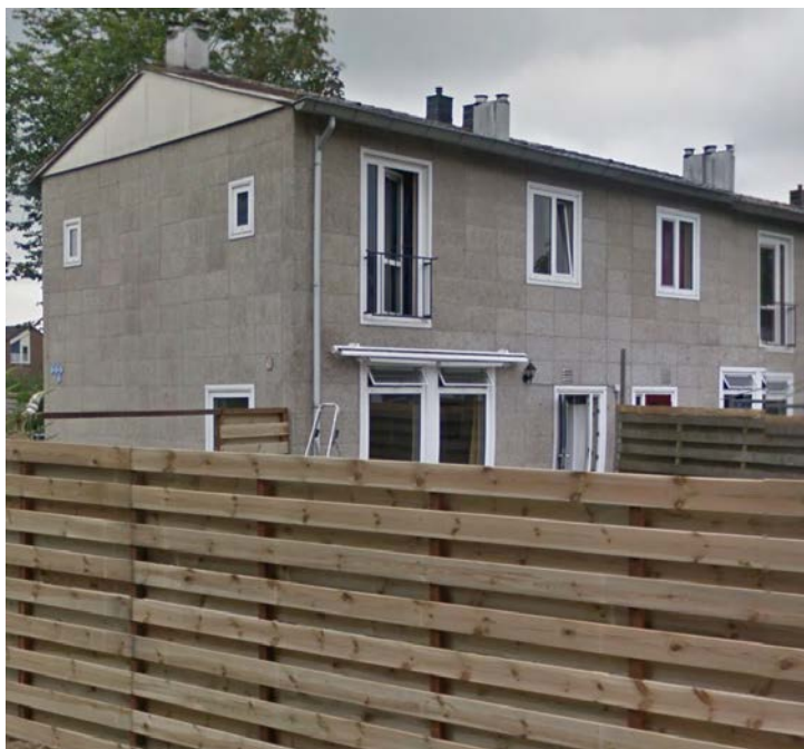
Woldkade, mei 2014, achtergevel
