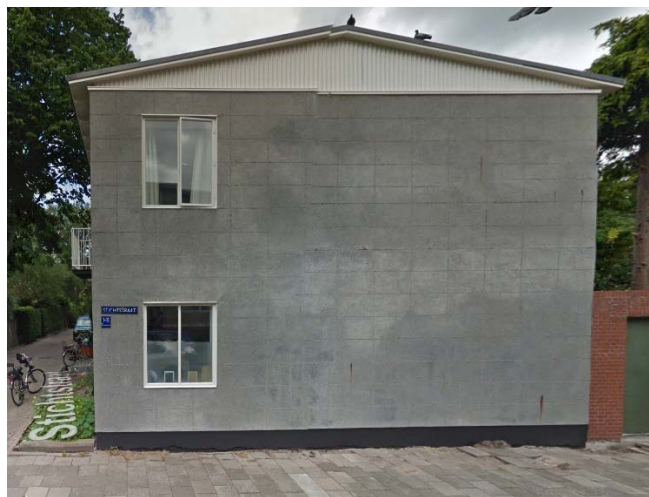
Stichtstraat juni 2014 achtergevel en kopgevel 13 panelen + passtuk diep
