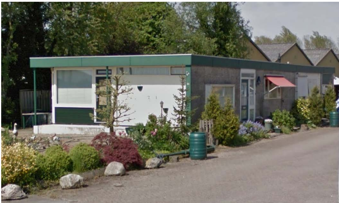
Afbeelding 8: MESA-bungalow op het voormalige bedrijfsterrein van MESA in Ten Post. De karakteristieke betonpanelen zijn zichtbaar in de lange gevel (Afbeelding: google streetview, dd. 9/12/2016).
