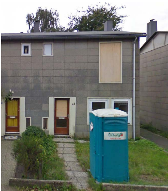
Aan het verbouwen, september 2010
