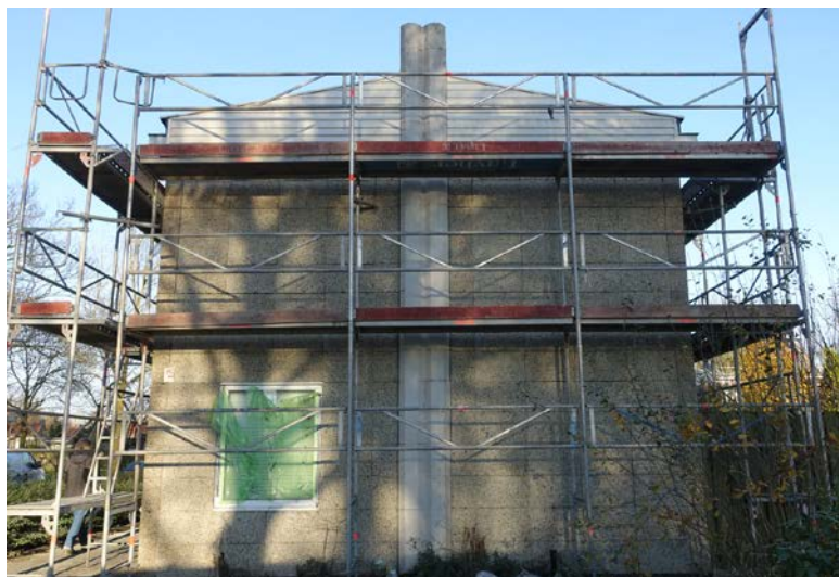
Renovatiewerk in Eindhoven (2016)
