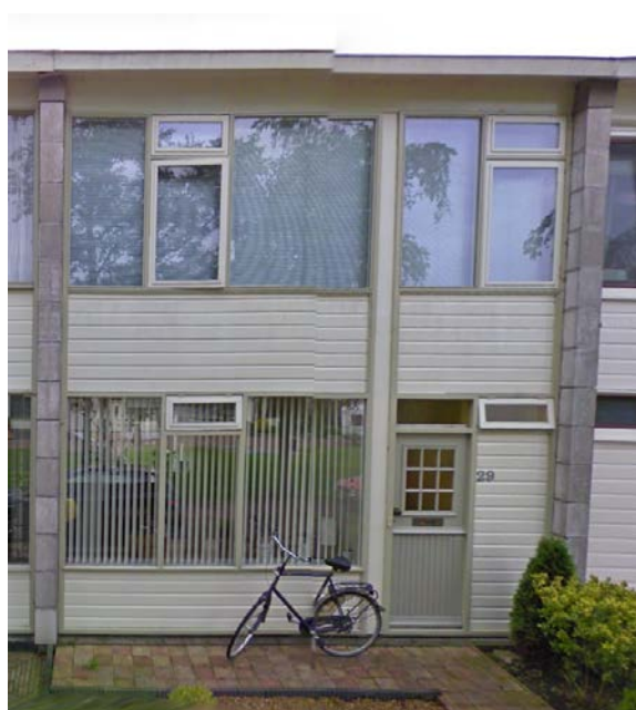
Voorgevel met penanten in beton
