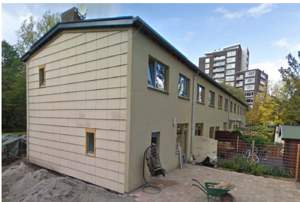
Perenlaan, oktober 2009, kopgevel en achtergevel
