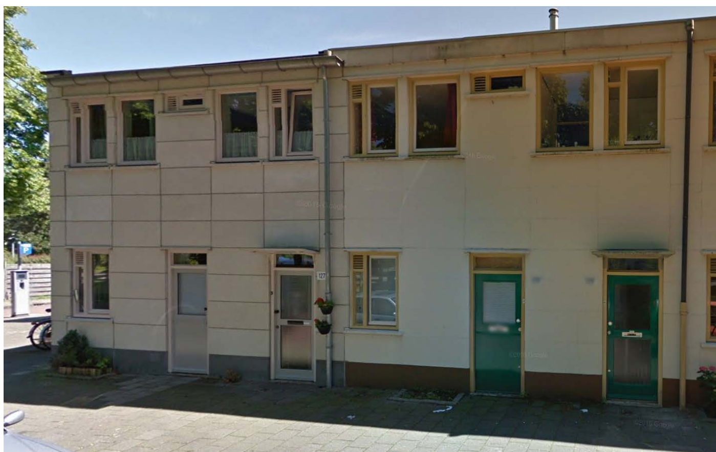
Hugo de Vrieslaan 129 juni 2014, linker woning gerestaureerd, gevelpanelen, dakrand en goot. Rechterwoning geschilderd, dakrand
