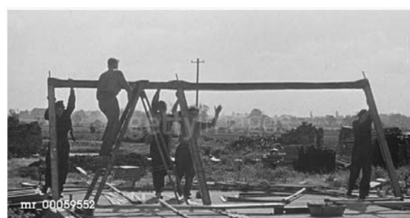
Afbeelding 10: Stills uit Country houses (zie noot 1). Plaatsing van de draad, ter wapening van het betonelement (a) waarvan de uiteinden gebruikt werden voor het bevestigingen van de elementen (b). De gevelelementen werden seriematig gemaakt en als laatste stap voor de verharding werd een laagje fijn grind ingetrild (c). Kenmerkend voor het UK-Airey-systeem zijn de betonnen spanten (d).
