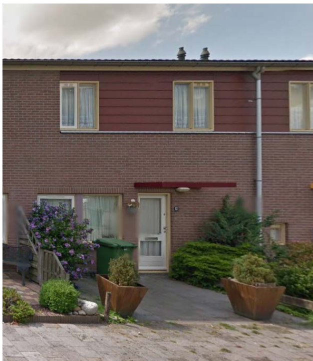
De Ruyterstraat juli 2014 voorgevel
