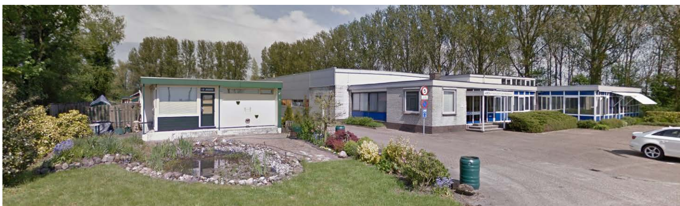
MESA-bungalow op het voormalige bedrijfsterrein van MESA in Ten Post. De karakteristieke betonpanelen zijn zichtbaar in de lange gevel, Google streetview, mei 2016.
