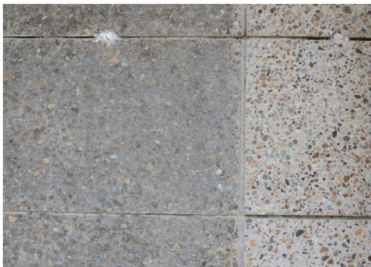
Afbeelding 49: Gevelreiniging, en na-isoleren van de spouw in Eindhoven Genderdal.
