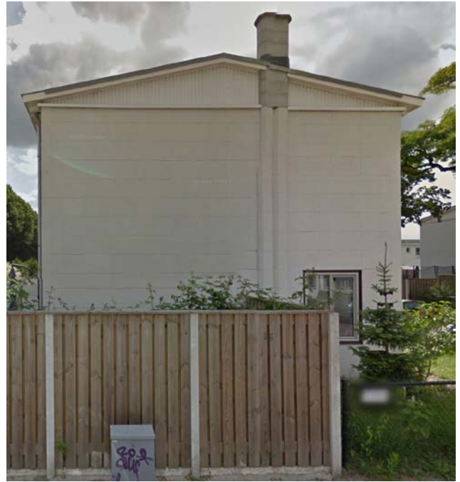
Veluwestraat, juni 2014, kopgevel
