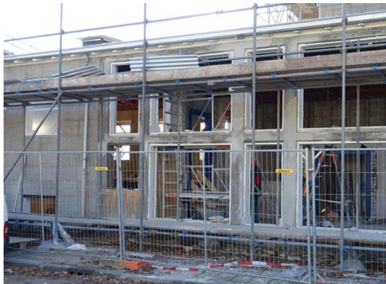
Renovatiewerk in Slotermeer (2016)
