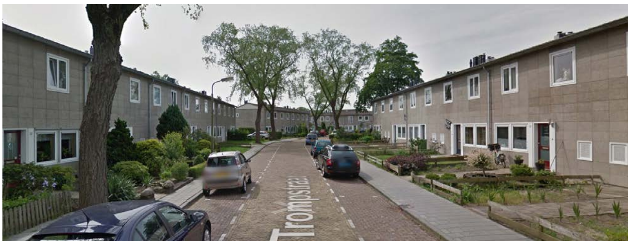
Trompsstraat, mei 2014, straatbeeld
