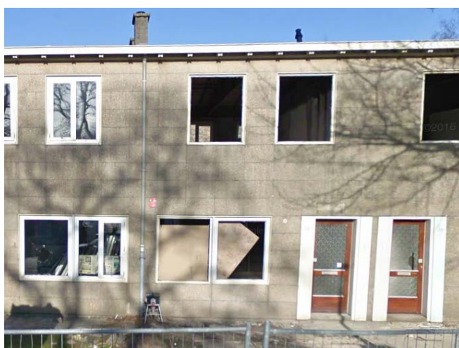
Veluwestraat, maart 2009 in renovatie
