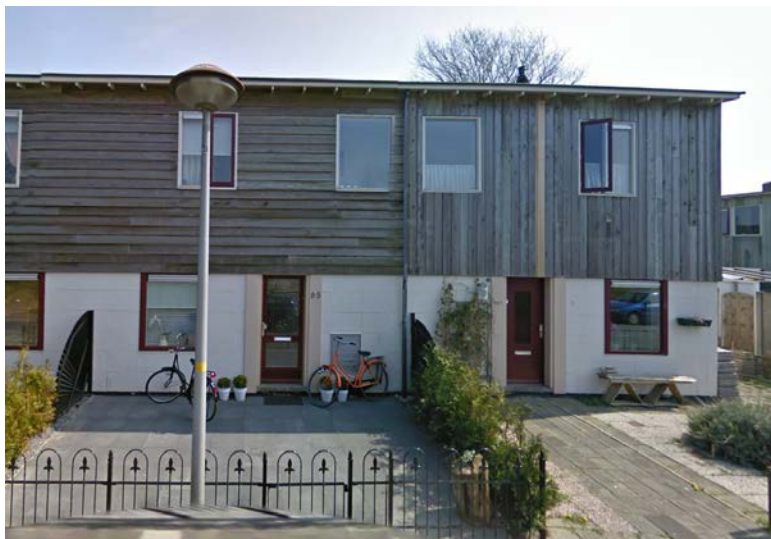
Hortensiastraat, april 2009, 9 panelen + deur (2 panelen)
