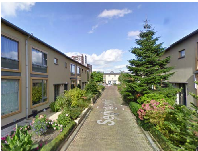
Seringenhof 9, oktober 2009, gevels stucwerk
