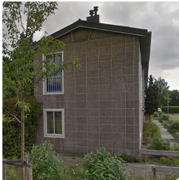
Koppelweg mei 2014 7panelen + 2 passtukken + 2
