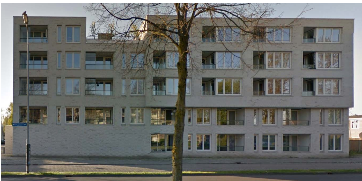
Karel de Grotelaan mei 2016 vervangende nieuwbouw portiek etage 4 hoog 54 woningen gesloopt
