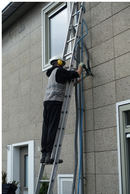
Afbeelding 48: Verwijderen oude voegen in Amersfoort
