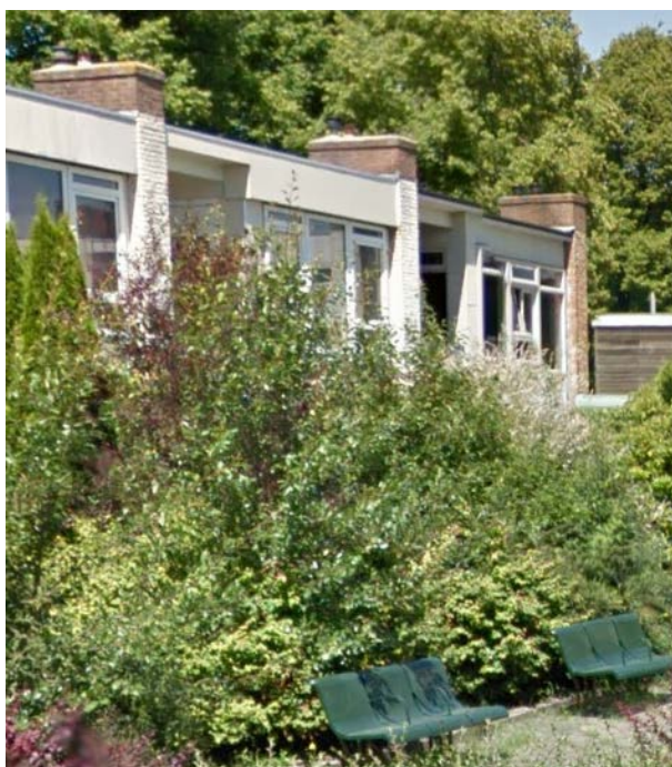
Hugo de Vrieslaan 129 juni 2014, laatste woning gerestaureerd, gevelpanelen, dakrand en goot. Rechterwoning geschilderd inclusief schoorsteen, dakrand en kozijnen kunststof Kopgevels bekleed en geschilderd
