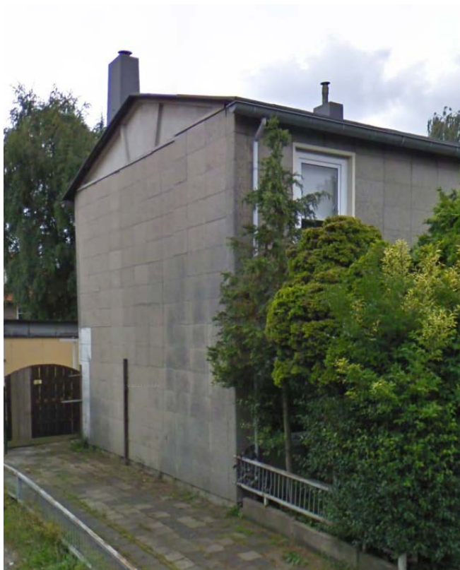
Kopgevel, september 2010, 10 panelen en 2 hoekstukken
