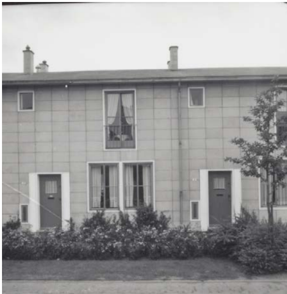
Afbeelding 13: Plasticiteit in de gevel. Links betonnen kaders rondom de vensters en de voordeur, rechts een veel vlakkere gevel door het ontbreken van de betonnen kaders. (Foto's: Carel Blazer, via Stadsarchief Amsterdam)
