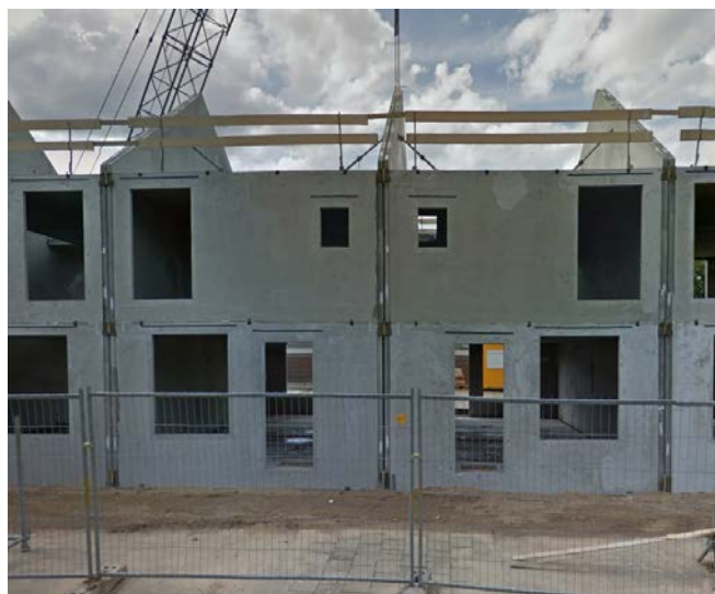
mei 2015 vervangende nieuwbouw 12 woningen
