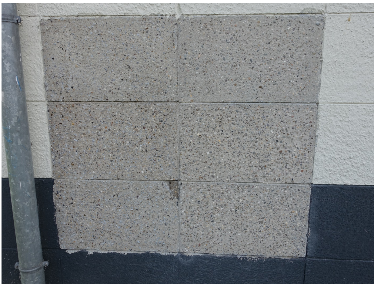
Renovatie 18 april 2016 (H. Zijlstra) Gevelpanelen van verf ontdaan, proefvlakken.
