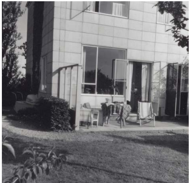
Afbeelding 13: Plasticiteit in de gevel. Links betonnen kaders rondom de vensters en de voordeur, rechts een veel vlakkere gevel door het ontbreken van de betonnen kaders. (Foto's: Carel Blazer, via Stadsarchief Amsterdam)
