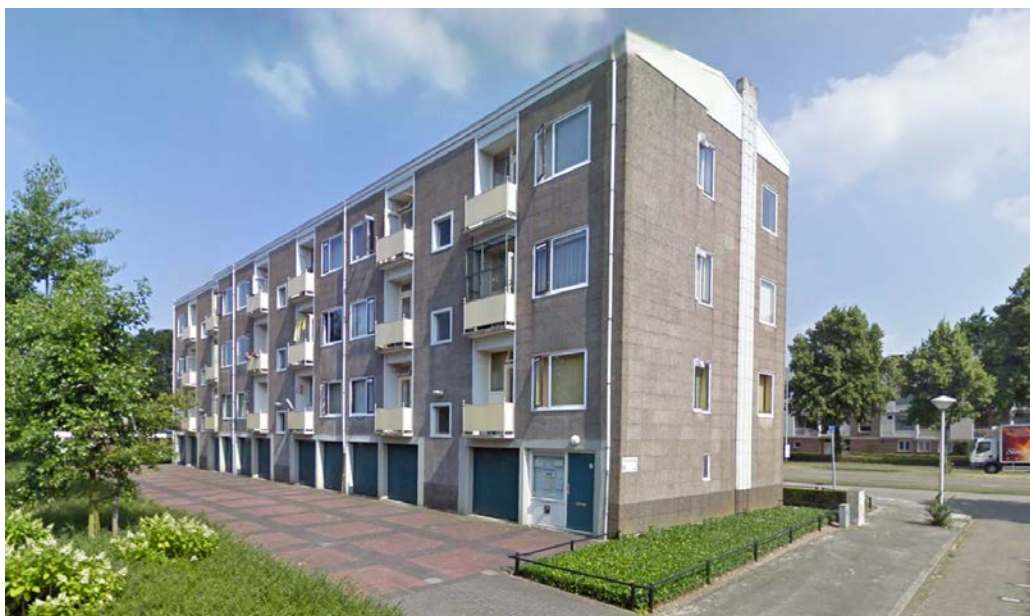
Spontinistraat, Karel de Grotelaan juni 2009 achterzijde van het blok
