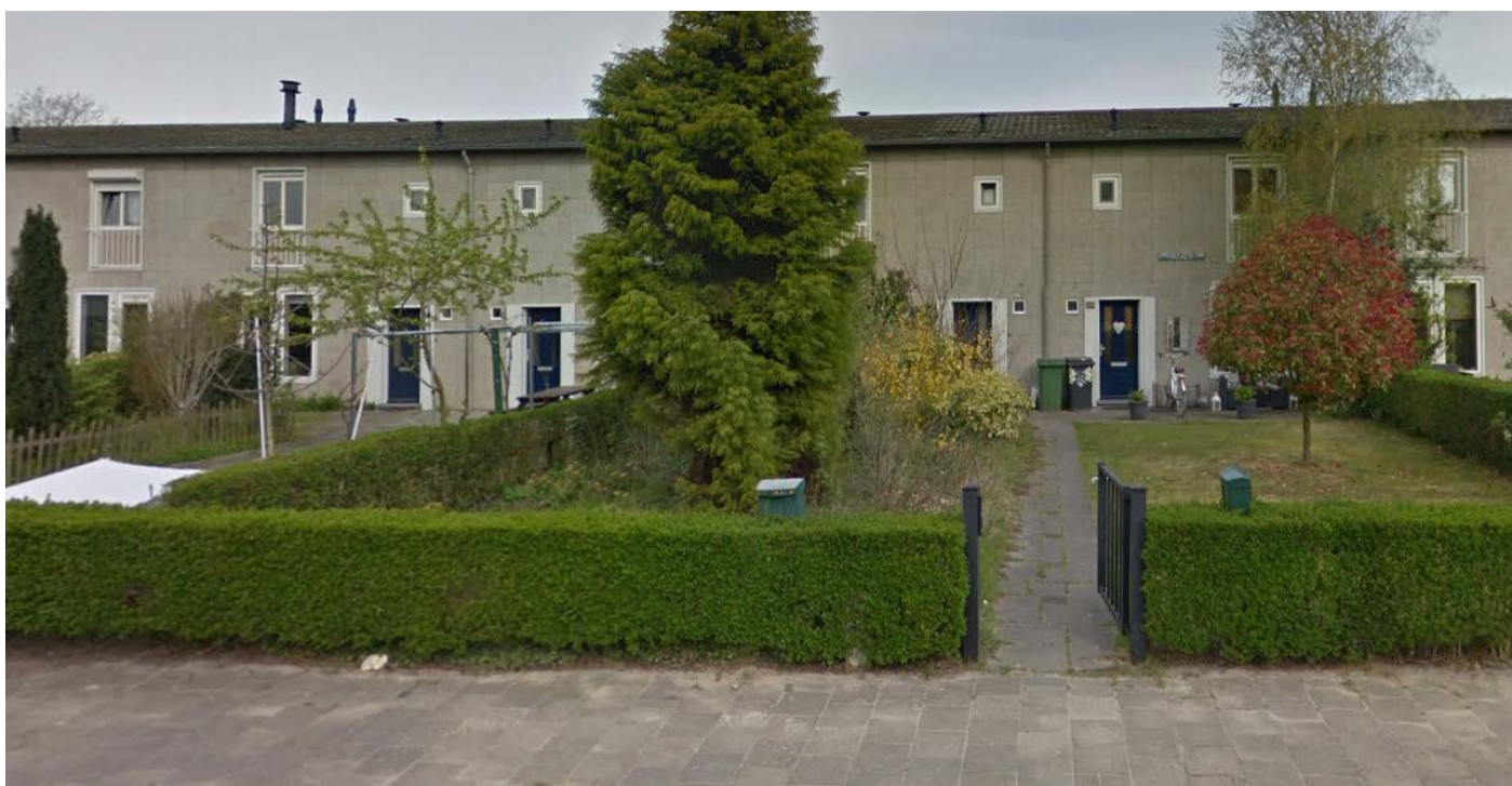
Sprenger van Eykiaan 28, april 2016, voorgevel
