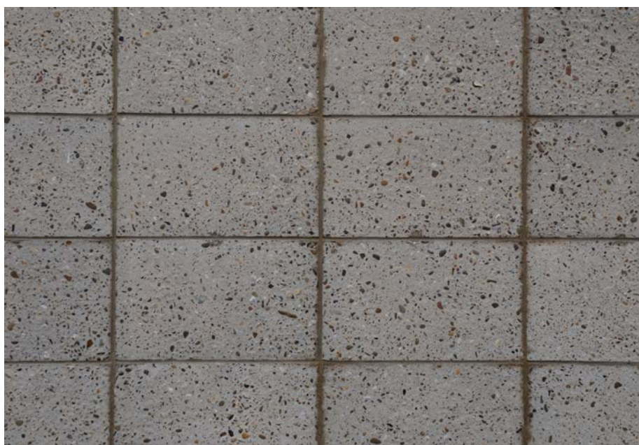
Afbeelding 50: Nieuw voegwerk en gerepareerde inspuitsgaten voor het na-isoleren in Amersfoort.
