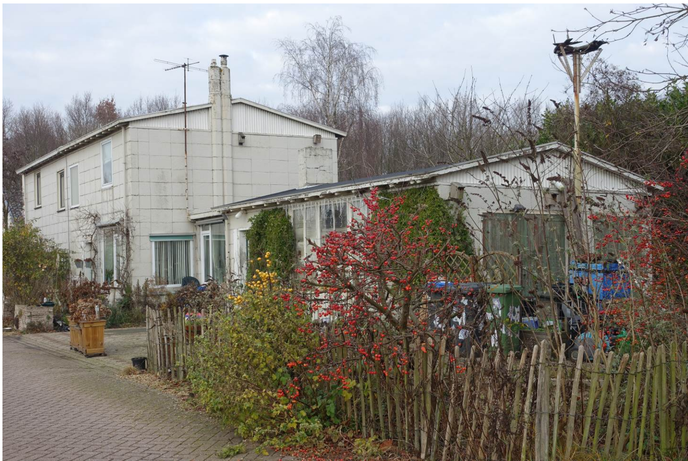
2 woningen en aanbouw, gevels geschilderd, H. Zijlstra 2016
