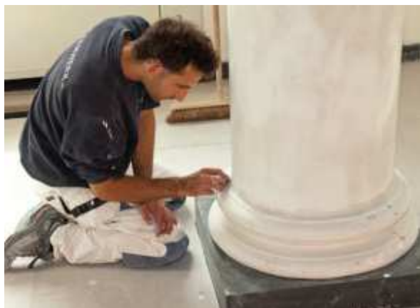
Fig. 39. Raad van State, Den Haag: Stucco lustro van de balzaal (begin 19 e eeuw) wordt gerestaureerd door de firma Leemwerk (Uit: Mebest, 06, 2011).
