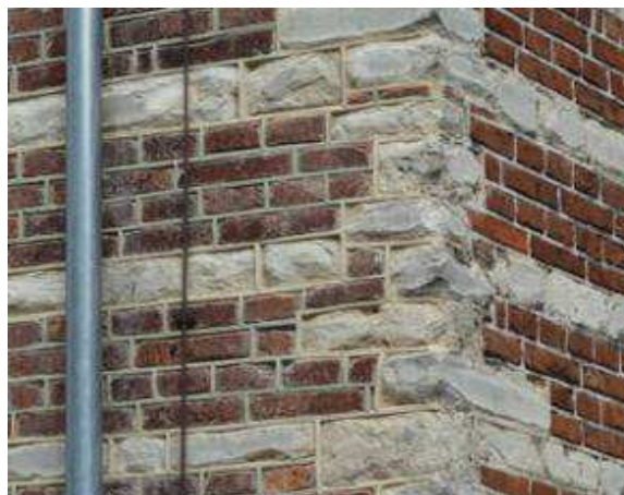
Fig. 1. Het huis van Paus Adriaan in Utrecht, Nederland: de (historisch incorrecte) gesneden voegen (links) veranderen het uiterlijk van de gevel.
