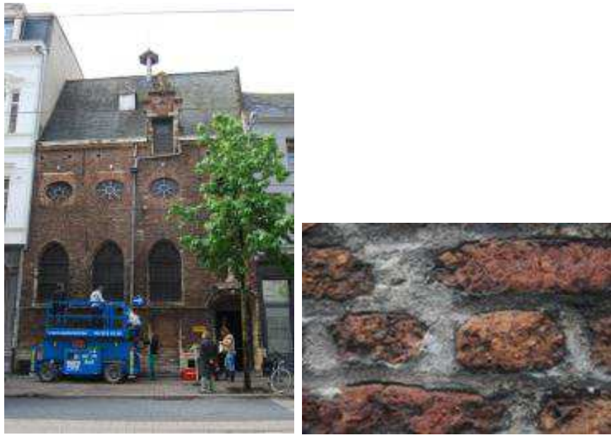
Fig. 22. Schoemakerskapel in Antwerpen, België, tijdens de inspectie.
