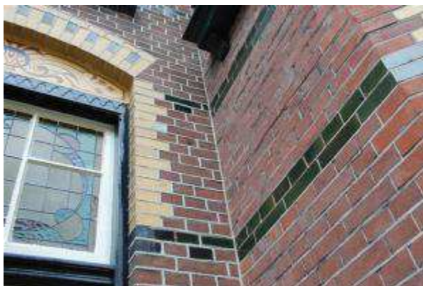
Fig. 4 Huis aan de Hertog Govertkade 14 in Delft uit ca. 1910 met originele dunne voegen (rechts) vervangen door gesneden voegen (links).
