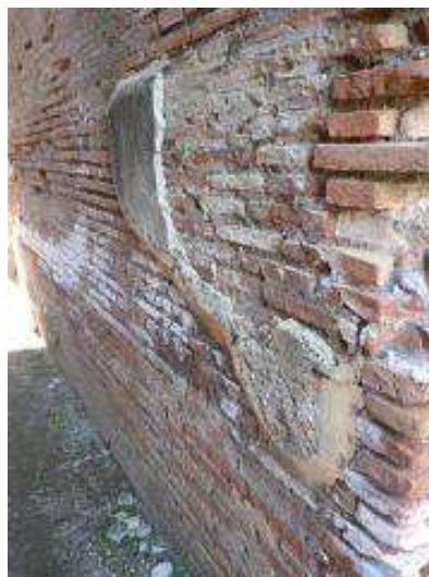
Fig. 8. Ostia Antica, Italië, havenstad van het oude Rome: Pleister sporen op de muur van een gebouw (Foto R. van Hees).
