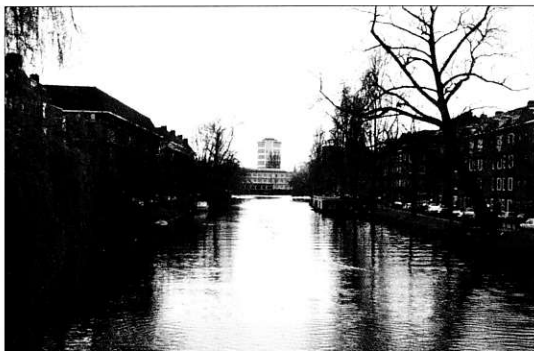
Zicht vanaf de brug over het Amstelkanaal op de voormalige Rijksverzekeringsbank.
