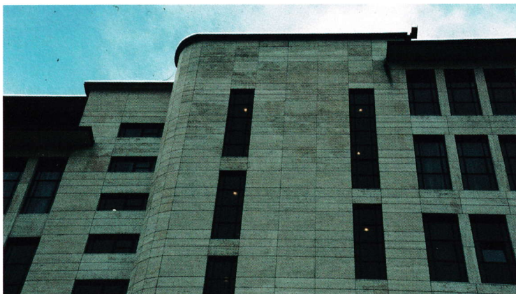
Nieuwe gladde gevel van de hoogbouw. De ronde ramen in het trappenhuis zijn verdwenen.
