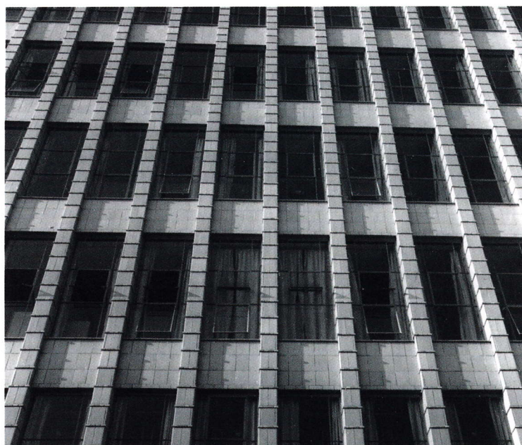
Deel van de oorspronkelijke gevel van de achterbouw, met penanten tussen de borstweringen.
