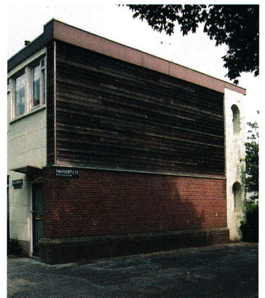
Kopgevel na renovatie.
