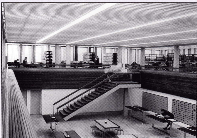
Het oorspronkelijke atrium van de bibliotheek in 1966.
