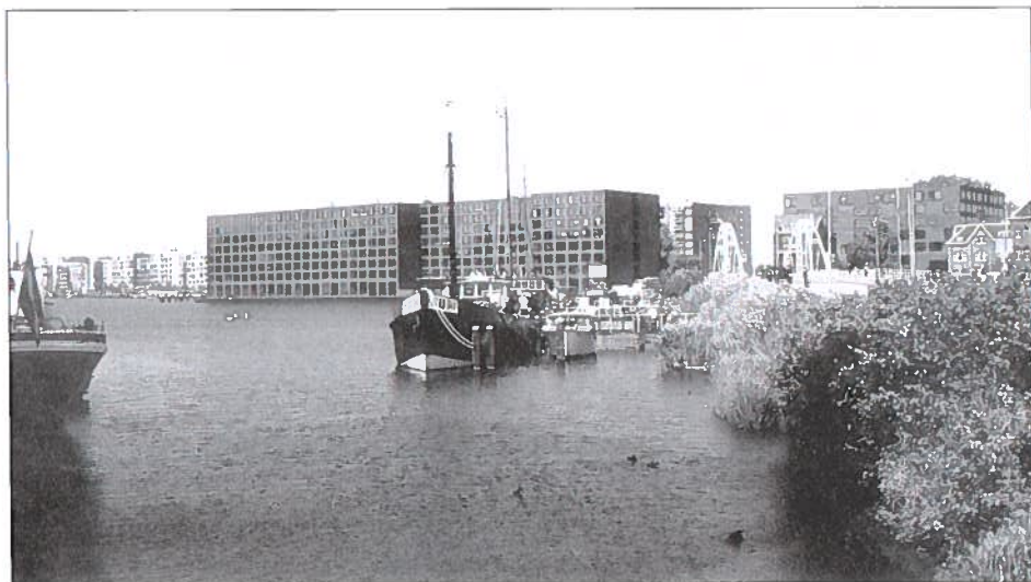
Diener & Diener, Woningbouwcomplex KNSM-eiland, 1998-2001, links het Langhaus, rechts van de brug het Hofhaus
