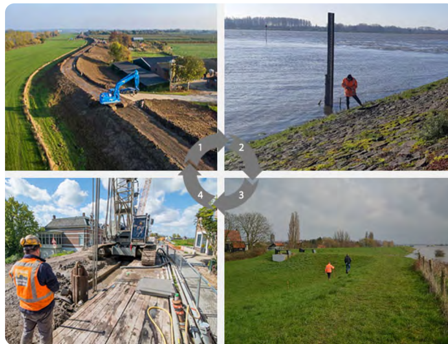
Figuur 2: Voorbeeld van activiteiten voor asset management van dijken: foto 1 en 4 versterking, 2 en 3 inspectie. Foto's door respectievelijk HWBP (2018, p.103) / Pascal Ogink, Hoogwaterbeschermingsprogramma, Wouter Jan Klerk en Mark van der Krogt.
