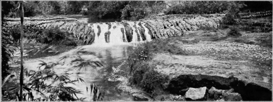
Foto No. 1. Dam Ngelo.
