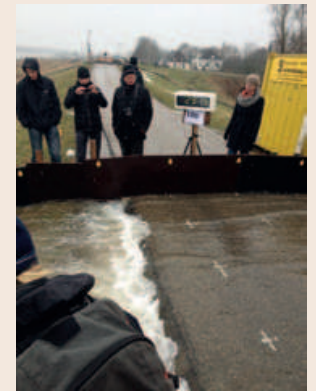
Figure 4. Wave overtopping experiment at Millingen aan de Rijn (Photo courtesy Juan Pablo Aguilar-López).
