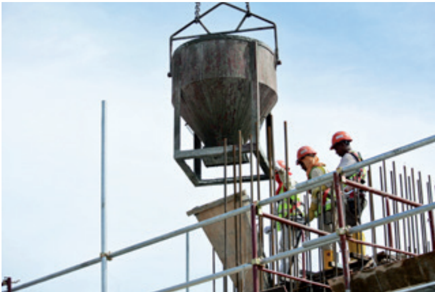
Figuur 12: Betongieten is een nauwkeurig geplande logistieke operatie
