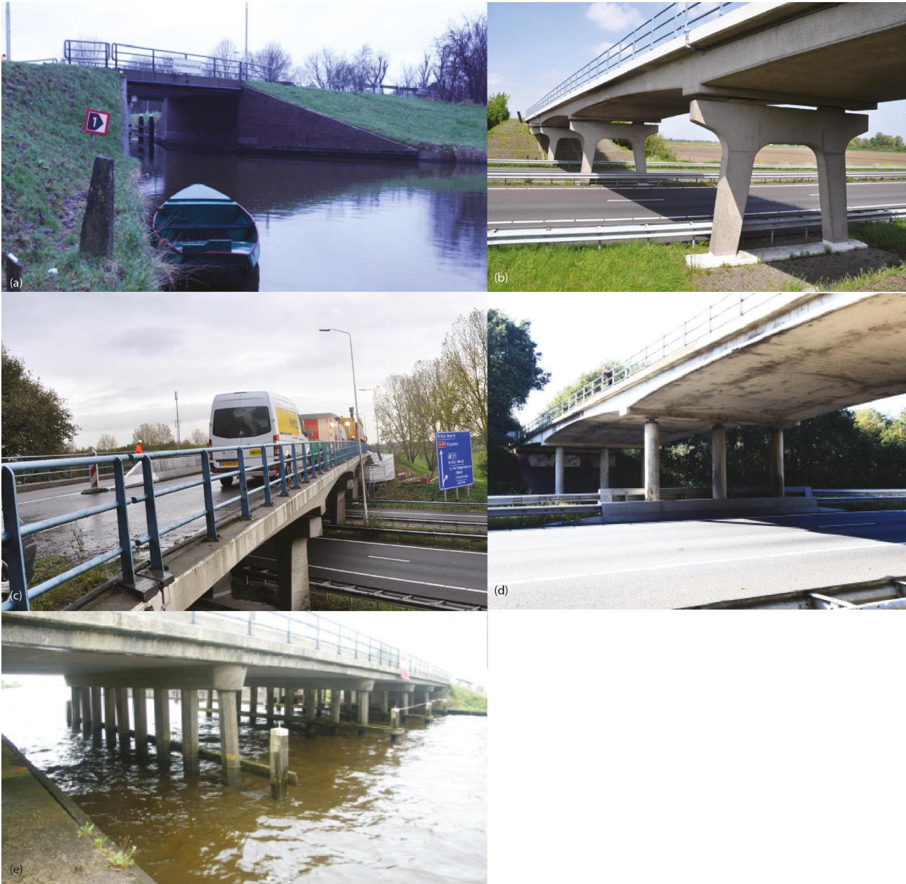
FIGURE 1: Overview of tested bridges: (a) Halvemaans Bridge; (b) Viaduct Zijlweg; (c) Viaduct Vlijmen Oost; (d) Viaduct de Beek; (e) Ruytenschildt Bridge (collapse test).
