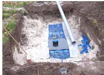
Aanleg infiltratiekratten onder een vijver
