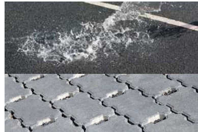
Waterdoorlatend asfalt en bestrating
