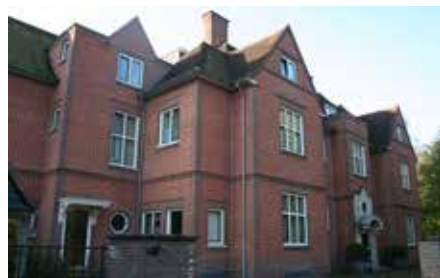
11. Villa Duynrose aan de Tapijtweg was onderdeel van het noodziekenhuis Zuidwal, dat enkele weken Rotterdamse vluchtelingen opving. Foto Just de Leeuwe, 2017.
