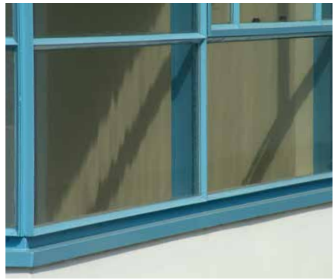
FIG. 5.34 Detail of the drawn single glass at one of the corners of the Main Building after restoration in 2003 / Taco Hermans, Rijksdienst voor het Cultureel Erfgoed
