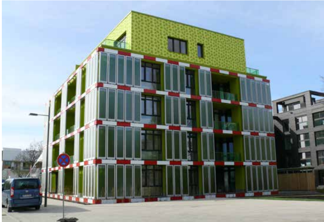
FIG. 2 Bioreactorfacade at the BIQ Das Algenhaus
