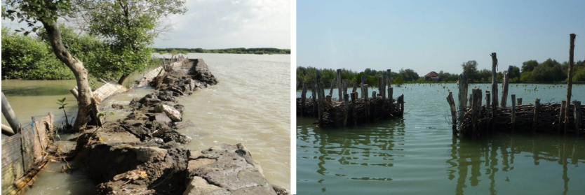
Fig. 9: Kustlijn erosie Indonesië bij harde verdediging (links) en Building with Nature pilot maatregel voor mangrove ontwikkeling (Demak, Indonesië, rechts)
