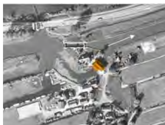
ILLUSTRATIE 4.28 Tussen-boezemgemaal De Ruiter.
