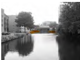
ILLUSTRATIE 7.35 De trechtervormige kade voor het gemaal.
