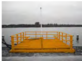
ILLUSTRATIE 7.100 Inlaat van Rottewater uitgewerkt als balkon.
