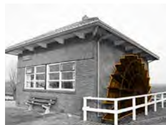
ILLUSTRATIE 3.40 Dieselmengemaal met scheppraad: vele combinatie van aandrijving en opvoering zijn mogelijk zoals hier bij het gemaal Langerak.
