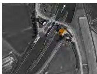
ILLUSTRATIE 4.14 Boezemgemaal De Waakzaamheid.
