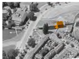
ILLUSTRATIE 4.33 Boezemgemaal Schiegemaal.
