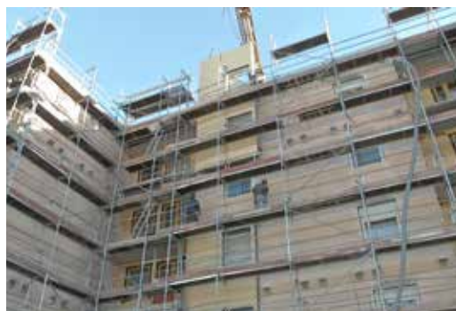
FIG. 7 SINFONIA project – panel installation (source: Benedikter Architekten)
