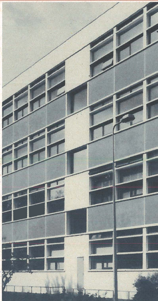
de verspringing in de gevel t.p.v. het trappenhuis
