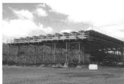
写真-2 桁の仮置き
