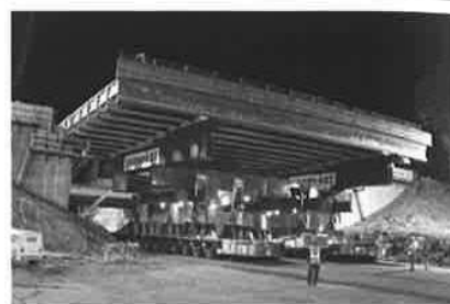
写真-3 SPMTでの架設
