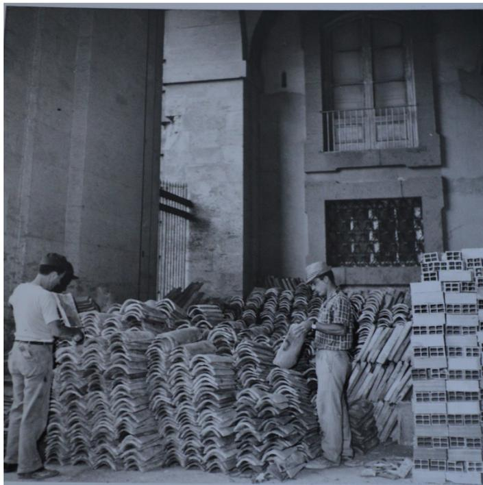
Fig. 4.40- Le tegole del tetto stoccate a piè d'opera, 1952?, Fototeca di Castel Sant'Elmo, Polo Museale della Campania, (negativo A.F.S.G. – n. 826 S.DOC).
