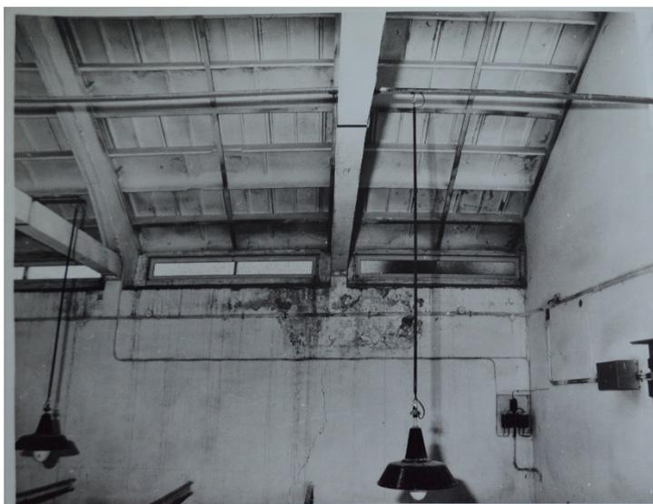
Fig. 4.67- Il degrado delle strutture di copertura, particolare del tetto al di sopra dei velari, 1982, Fototeca di Castel Sant'Elmo, Polo Museale della Campania, (negativo A.F.S.B.A.S. – n. 12249 M.).
