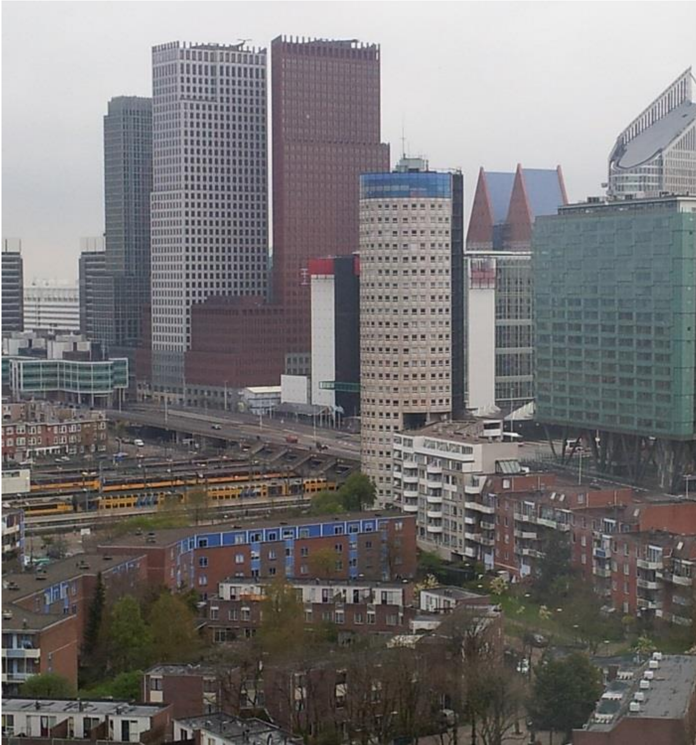
Bezuidenhout-West met hoogbouw op de achtergrond
