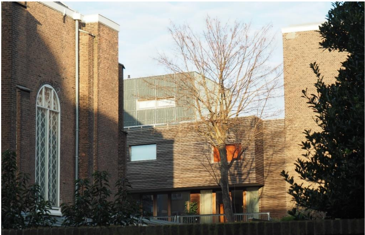
Figuur 3. Rond 2000 werden de eerste woningen met kruislaaghout CTL gebouwd in Den Haag in de Vondelstraat. Een van de eerste biobased experimenten. Helaas is het daarbij gebleven en is de bouwindustrie bij het verdichten teruggevallen in oude milieubelastende technieken en materialen. Foto: auteurs.
