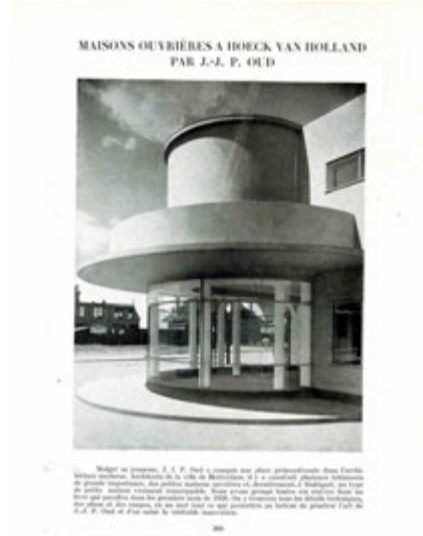
FIG. 5 'Maisons ouvrières à Hoek van Holland', Cahiers d'Art, octobre 1927
