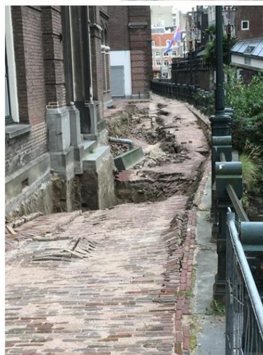
Figuur 3.2 Ontwikkeling sinkholes en uitbuiging kade [6] (foto's 1 sept 2020 ).
