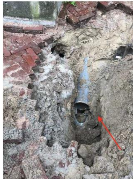
Foto 10: Afgebroken hemelwaterafvoer.
