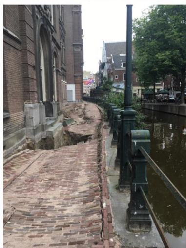
Figuur 3.2 Ontwikkeling sinkholes en uitbuiging kade [6] (foto's 1 sept 2020 ).
