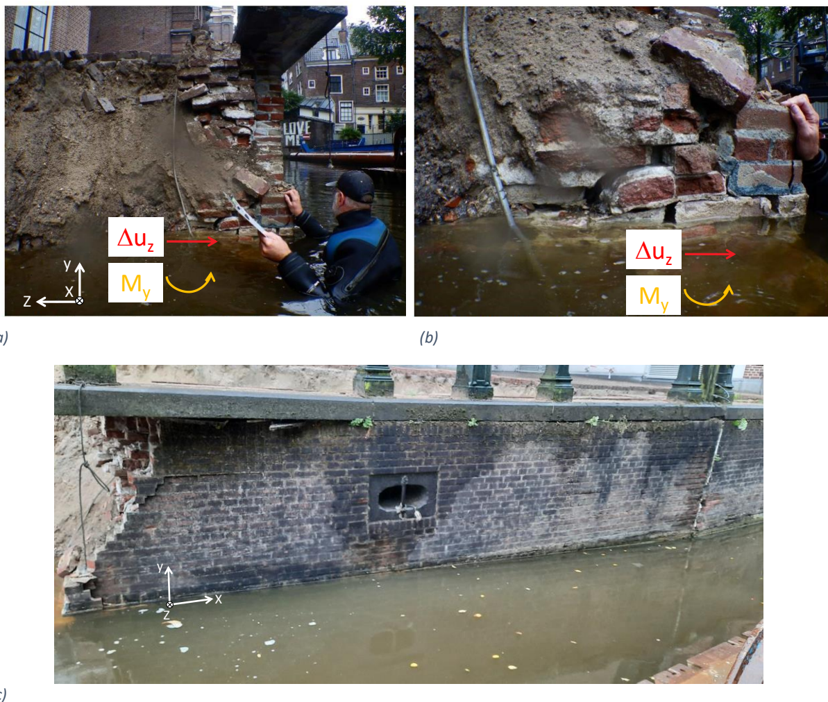
Figuur 6.4 – Westelijke scheur: (a) Potentiële vervormingen (in rood) en belastingen (in geel) die het scheuroppervlak creëerden, (b) Detail van het onderste deel in het yz-vlak, (c) Detail van de gehele scheur in het xy-vlak.
