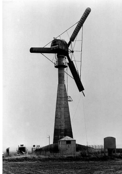
The Gedser wind turbine, J. Juul, Denmark, 1957
